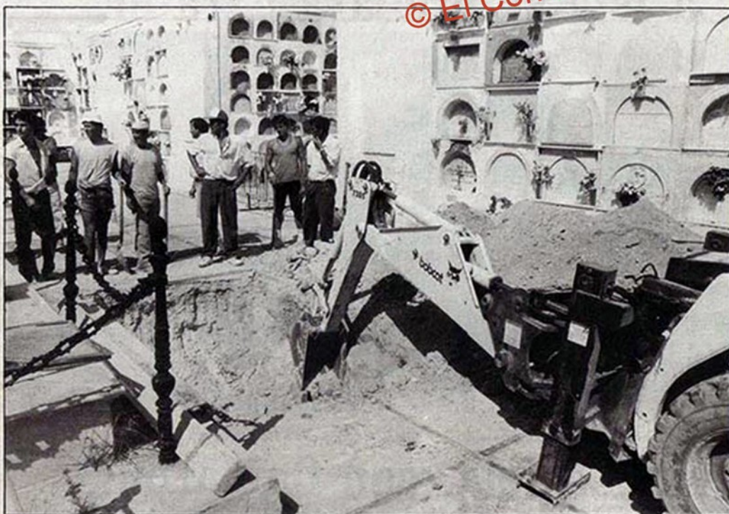
Trabajos en el cementerio isleño para preparar la tumba de Camarón
